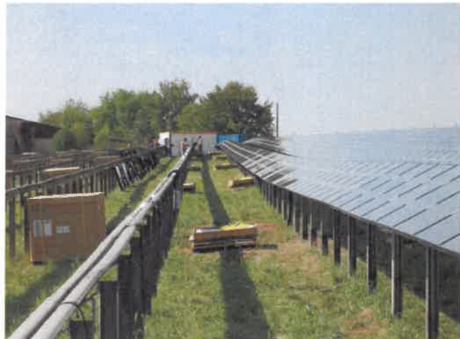
Abb. 4: Beispiel einer Freiflächen-Solaranlage während der Montage
