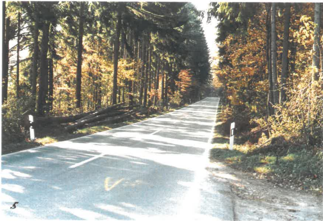
Bild 5: Blick von Nord-Osten nach Süd-Westen (Fahrtrichtung von Wittendorf nach Loßburg)
