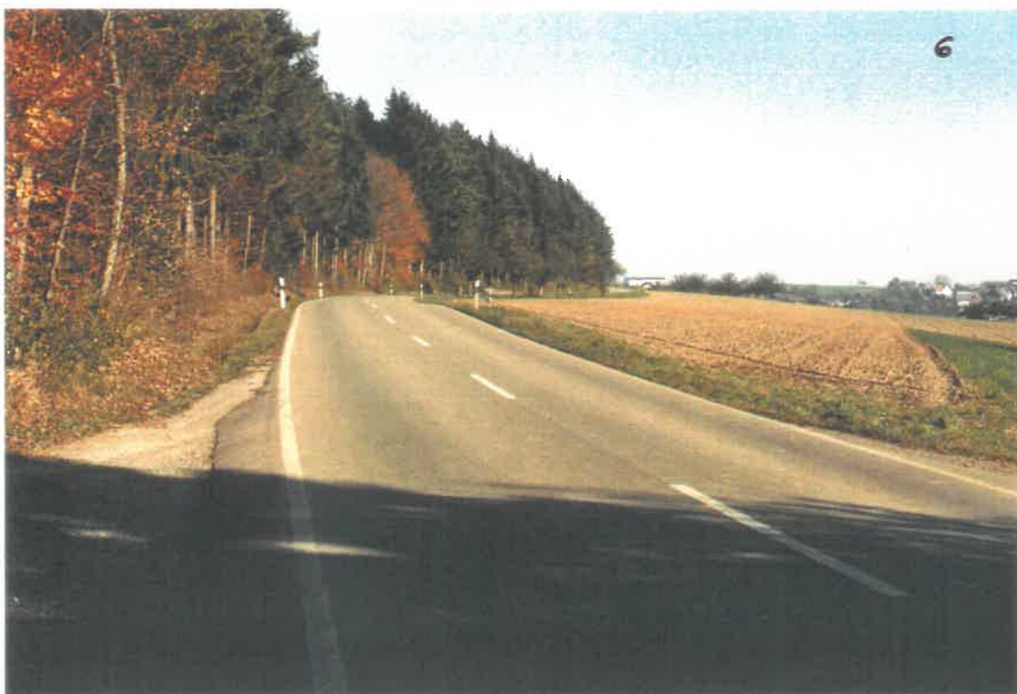
Bild 6: Blick von Süd-Westen nach Nord-Osten (Fahrtrichtung von Loßburg nach Wittendorf)
